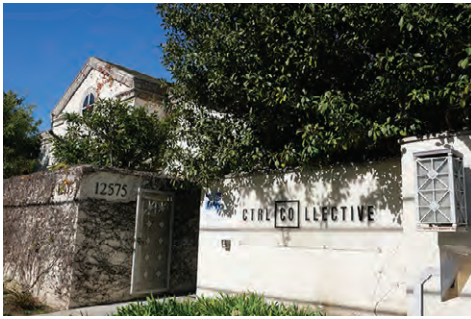
シリコンビーチと呼ばれるエリアにあるカリフォルニア支店外観。
