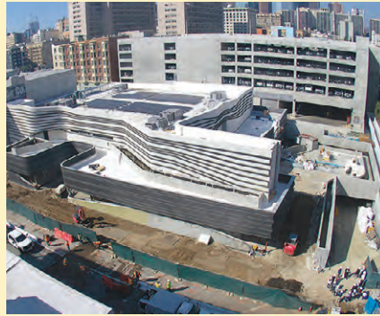
リトルトーキョーの新たなランドマーク、ポール・H・テラサキ武道館は、現在工事真っ最中。
